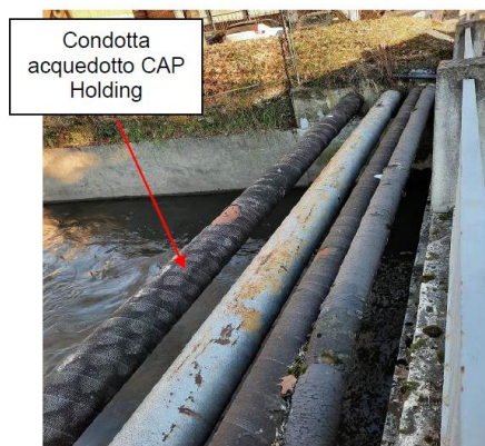
Figura 3: Serie di tubazioni situate adiacentemente al ponte
