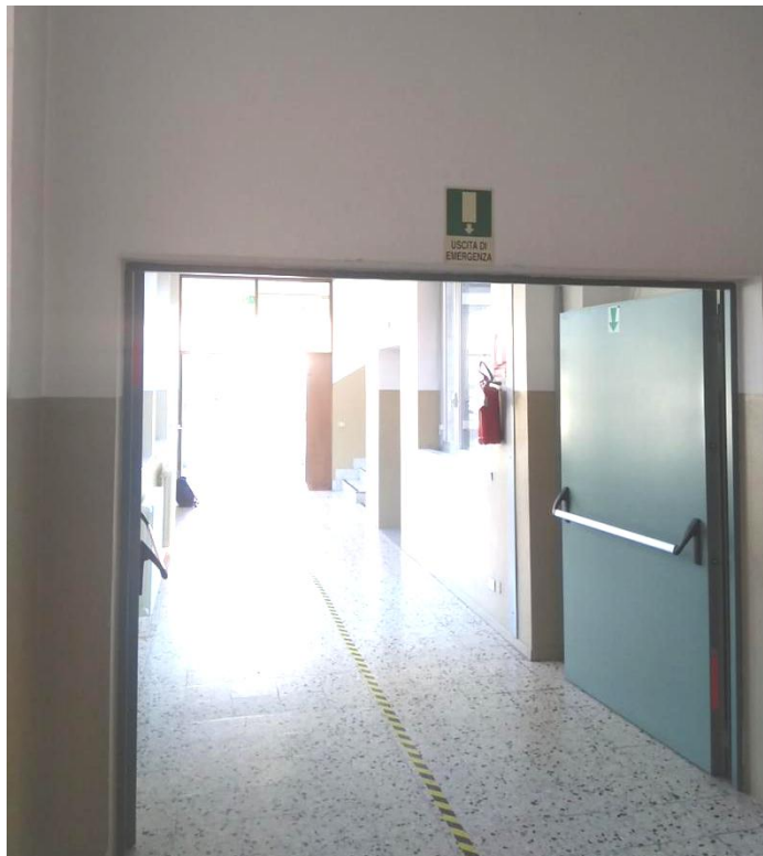
4_ Porta EI a tutti i piani per scala protetta da revisionare
