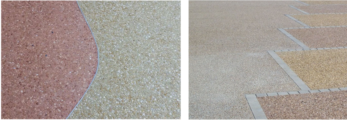
Fig. 26 – Esempi di pavimentazioni architettonica in seminato di cemento con inserti di formati e materiali diversi
